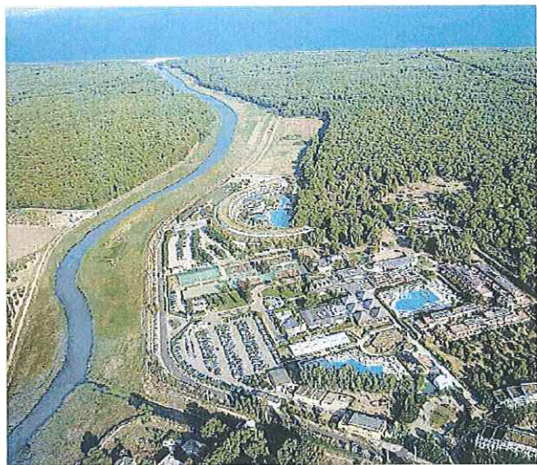
CASTELLANETA MARINA Il complesso turistico Nova Yardinia L'ACQUISIZIONE MPS, POPOLARE DI BARI E INTESA INSIEME ALLA CISA DI MASSAFRA. UN'OPERAZIONE DA 120 MILIONI DI EURO
